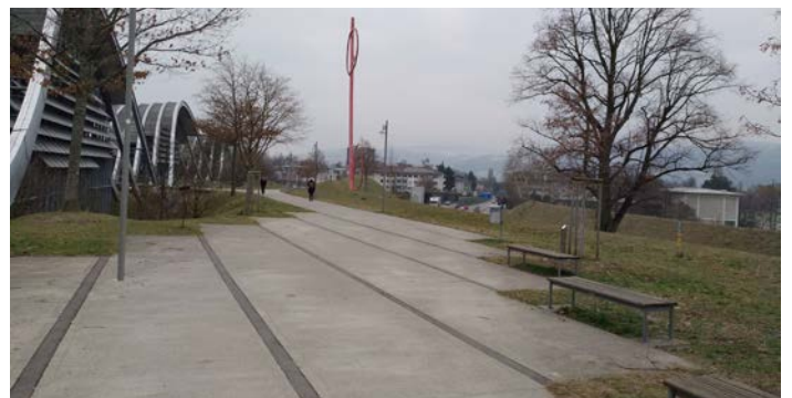
Abbildung 6: Detailskizze der Versickerung «über die Schulter» (links) und ein Fussweg, von dem das Niederschlagswasser auf den angrenzenden Grünstreifen abgeleitet wird, wo es flächenförmig versickern kann (rechts).
