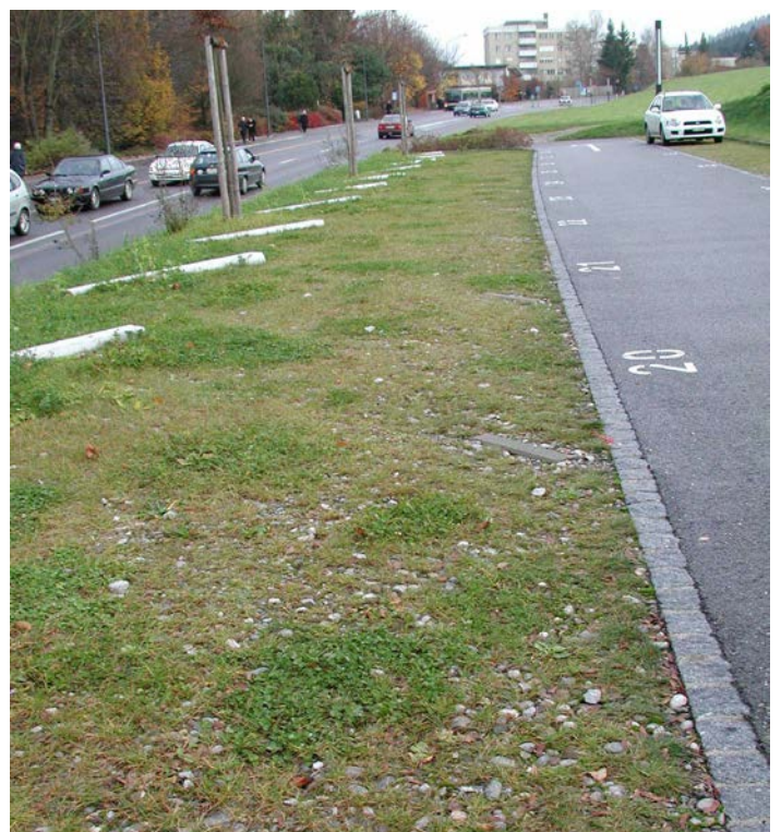
Abbildung 4: Detailskizze der Wirkung von Schotterrasen und Kiesflächen (links) und ein Beispiel eines mit Schotterrasen ausgebildeten Parkplatzes (rechts)
