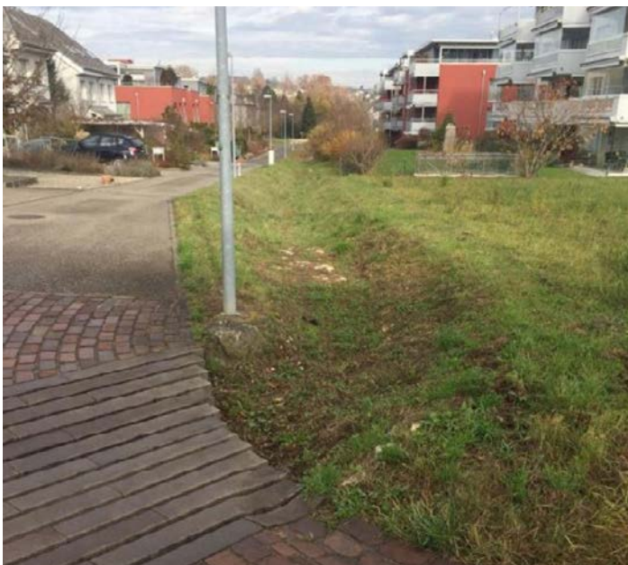
Abbildung 10: Die Fotos zeigen Gräben, in denen das anfallende Niederschlagswasser zurückgehalten und versickert wird. Links: Graben entlang einer Quartierstrasse, rechts: kleiner Graben zur Versickerung des Dachwassers auf einer Liegenschaft.
