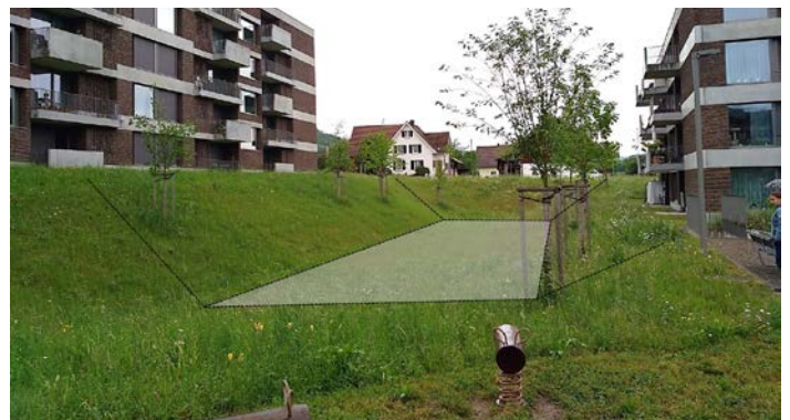
Abbildung 7: Skizze der Funktionsweise einer Versickerungsmulde (links) und Beispiele aus dem Siedlungsgebiet (rechts). Eine Detailskizze eines Versickerungsbeckens ist im Modul DA (Abb. 9) der VSA-Richtlinie zu finden.
