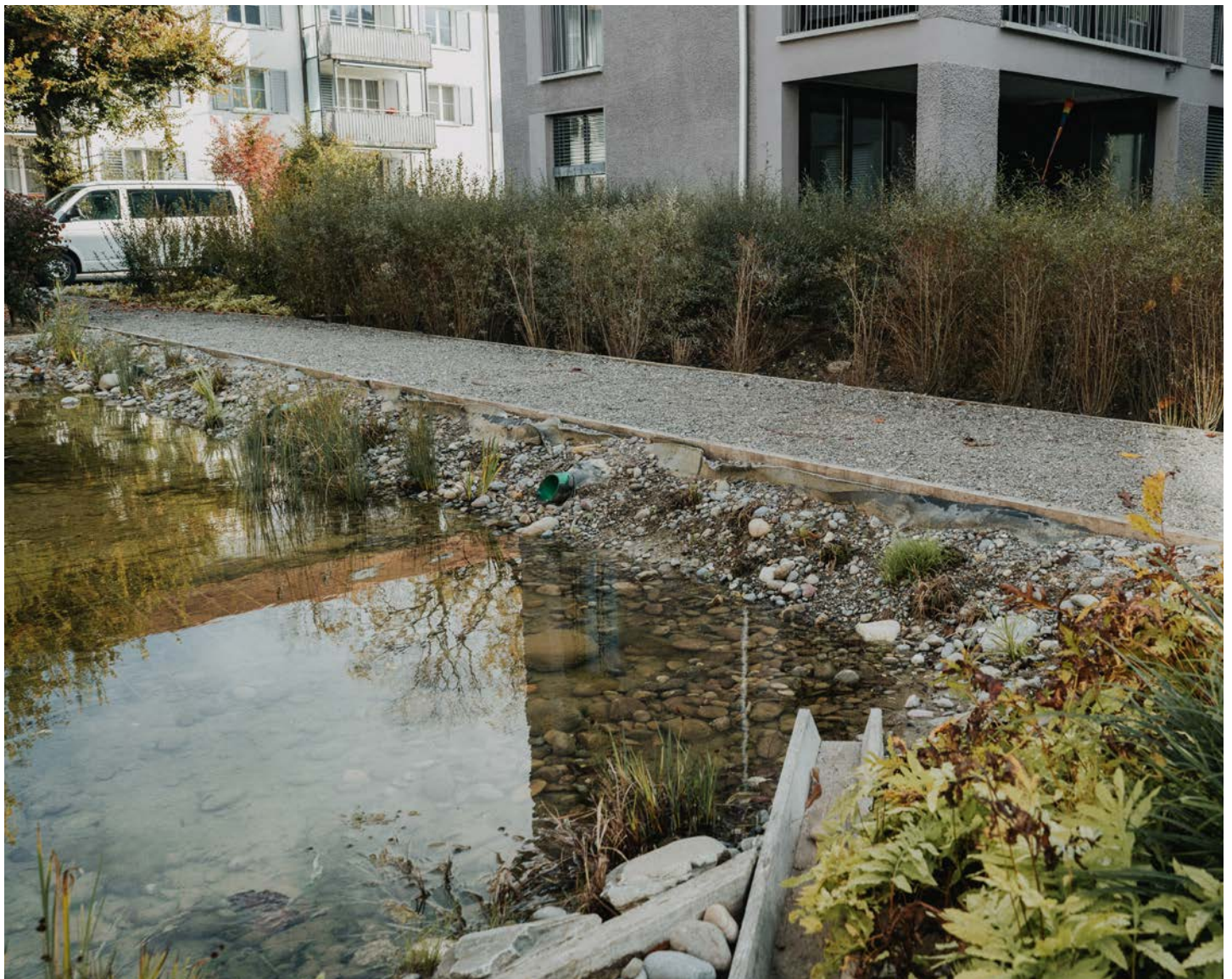
Abbildung 2: Retentionsteich als Element der Umgebungsgestaltung mit Überlauf (grünes Rohr im Bild) in Versickerungsmulde auf der anderen Seite des Weges
