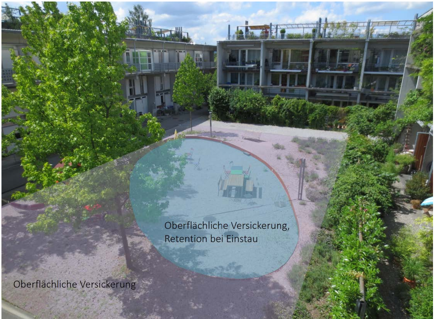
Abbildung 3: Beispiel einer gut in die Quartiergestaltung integrierten Siedlungsentwässerung: Im äusseren Bereich des Platzes wurde Schotterrasen (violett) und im Inneren eine Kiesfläche (blau) ausgebildet, die bei Starkregen als Retentionsvolumen dient und kurzfristig eingestaut werden kann.
