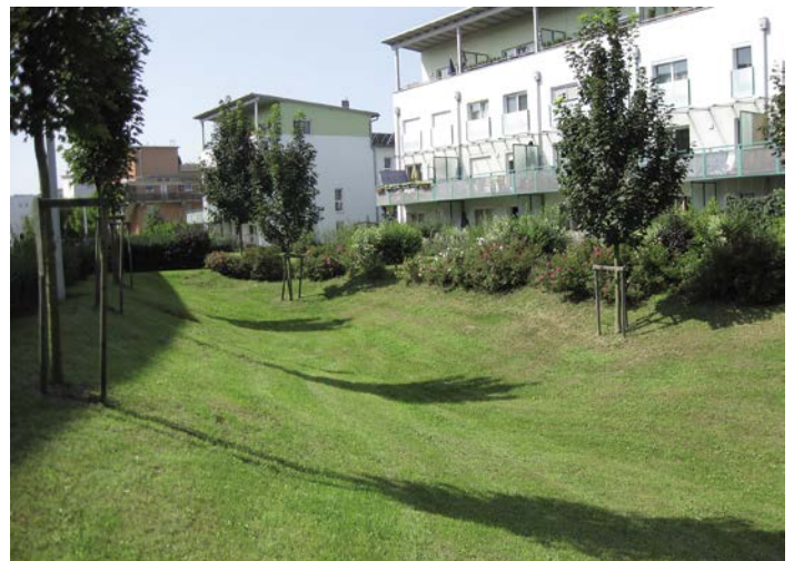
Abbildung 1: Beispiel eines gut in das Quartierbild integrierten Versickerungsbeckens.
