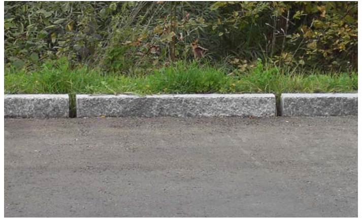
Abbildung 11: Entwässerung von Parkplatzflächen über die Schulter. Bei Starkregen wirken die Fugen der Stellriemen (rechts) wie ein Drosselorgan. Der Parkplatz wird temporär eingestaut.
