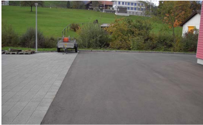
Abbildung 11: Entwässerung von Parkplatzflächen über die Schulter. Bei Starkregen wirken die Fugen der Stellriemen (rechts) wie ein Drosselorgan. Der Parkplatz wird temporär eingestaut.
